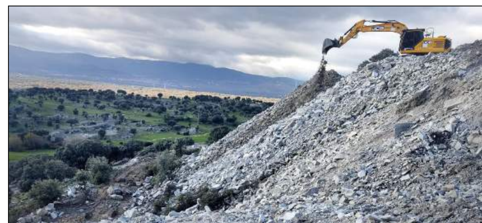
Remodelación topográfica según diseño geomorfológico
